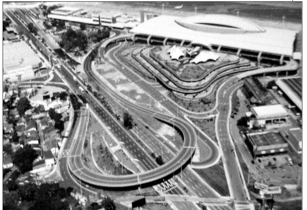
ACESSO - Estrutura facilitará tráfego de veículos que circulam pela área do aeroporto
