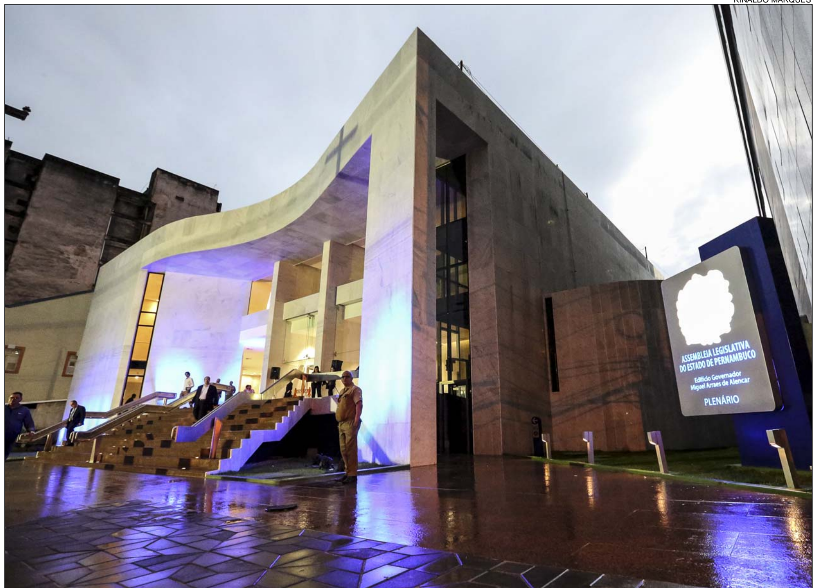
ESTRUTURA - Prédio ainda contará com três plenarinhos, onde serão realizadas as reuniões das comissões parlamentares
