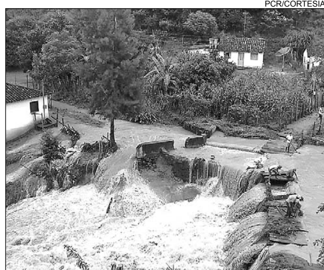
TEMPORAL - Áreas da RMR e interior foram inundadas
